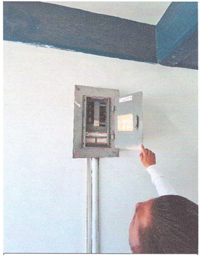
NC 2.- Tiene Huecos al frente del tablero
